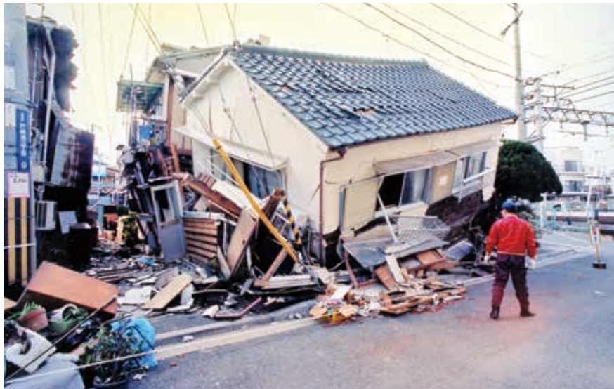
1995年1月の阪神大震災では、耐震性が不足する住宅が相次ぎ倒壊。「家が人を殺した」とさえ言われた
