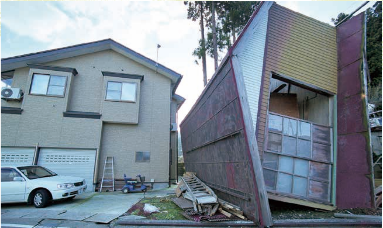
新潟県中越地震の被災地では、地盤の強弱や対策の有無で被害状況に大きな差がみられた=2004年11月
