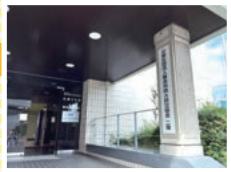
ビル正面から
