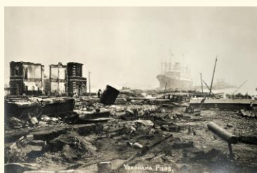
大きな被害を受けた 大さん橋周辺
