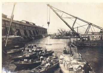
新港ふ頭でのクレーン船による岸壁復旧工事とみられる様子
