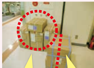
物件(商品)による 屋内消火栓設備の 操作障害
