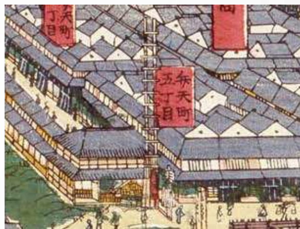
図Ⅱ 弁天町5丁目の火の見櫓（部分拡大）
