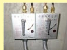
点検用閉止弁の例
